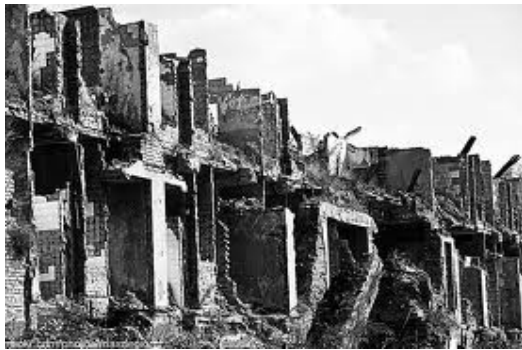
Mnoga lječilišta su djelila sudbinu gradova u kojima su bila smještena. Institut za fizikalnu terapiju i rehabilitaciju u Sarajevu po završetku rata 1995.
