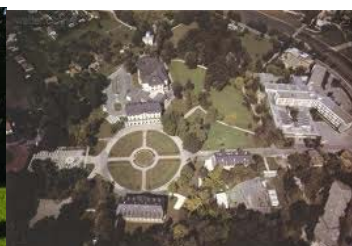
Kompleks hotela u blizini termalnog izvorišta, Ilidža-Sarajevo
